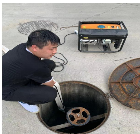
抽空雨水管道的水，并用自来水冲至 pH 呈中性
