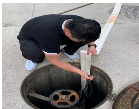
雨水闸阀口放置抽水泵
