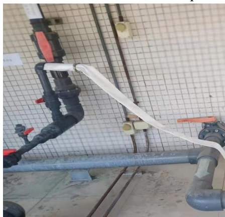
抽空雨水管道的水，并用自来水冲至 pH 呈中性
