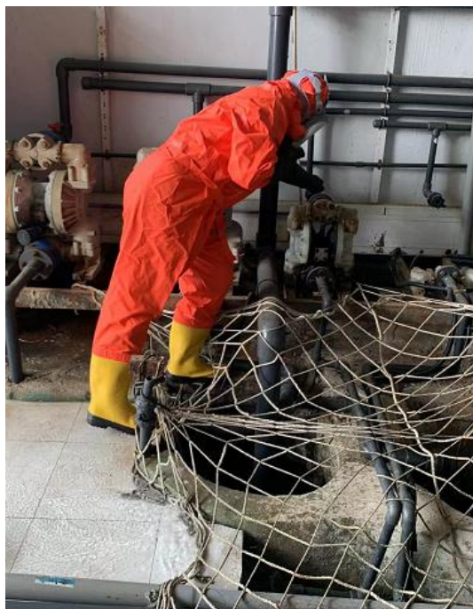
启动隔膜泵抽水
