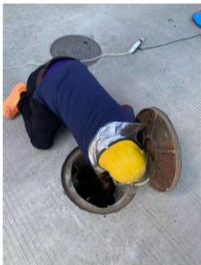
用挡板阻挡雨水口
