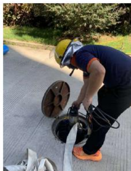
水泵放入雨水口，并接通管道
